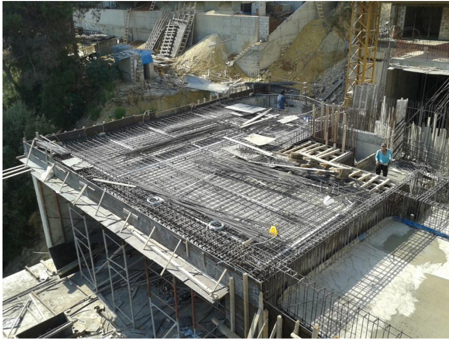
Roof Block A:
